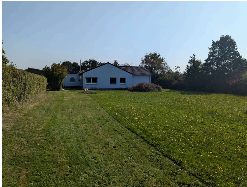
Foto 1: Blick auf das Projektareal in östliche Richtung
