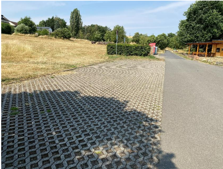
Abb. 18: Stellplatzfläche aus Rasengittersteinen
