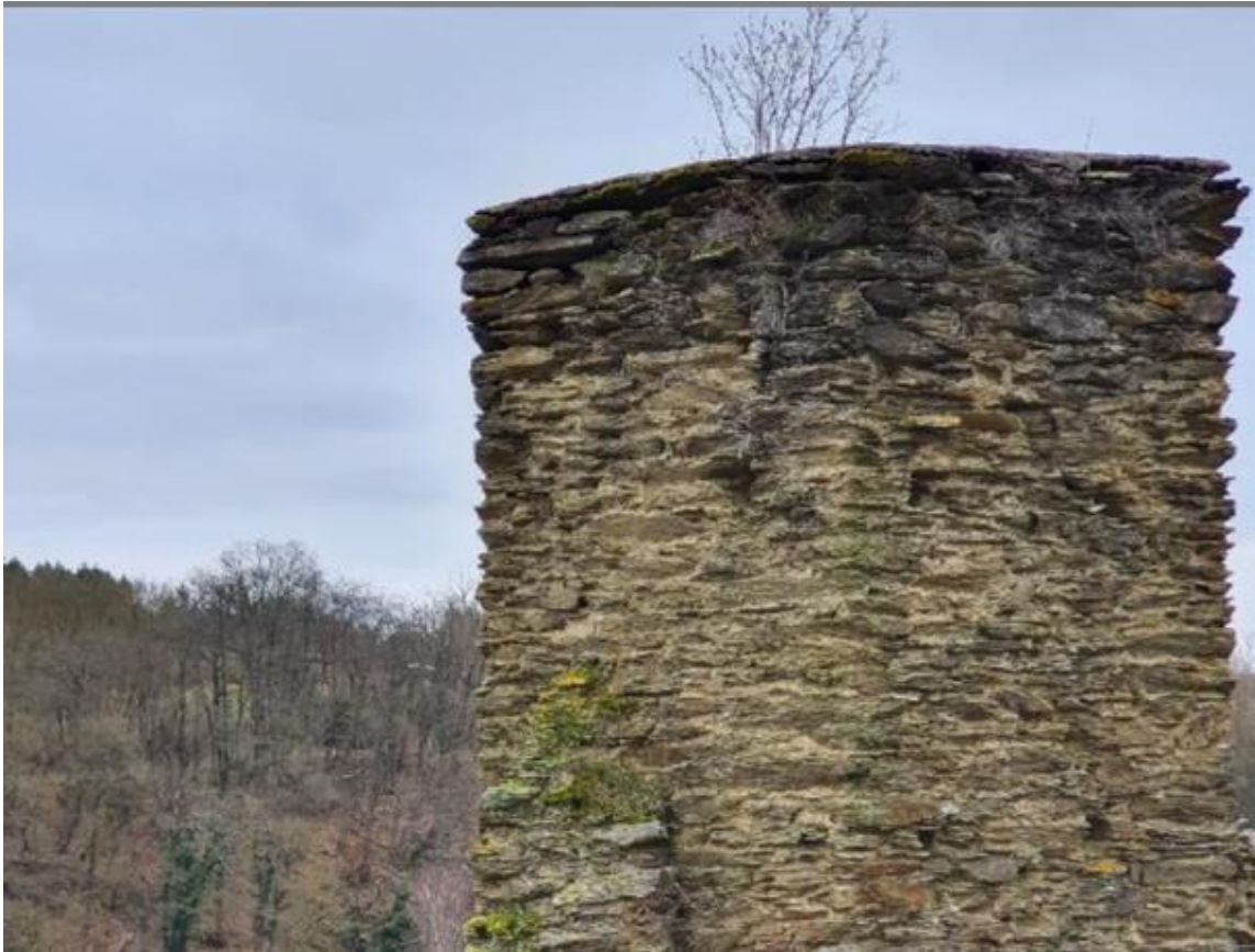
Ansicht Torunelle vor der Sanierung
