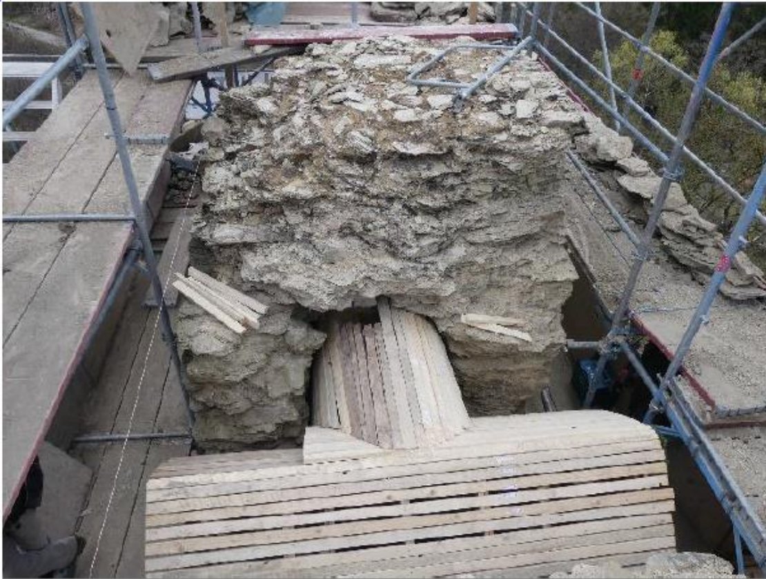
Aufmauerung eines Spitzbogens mittels Bogenschalung
