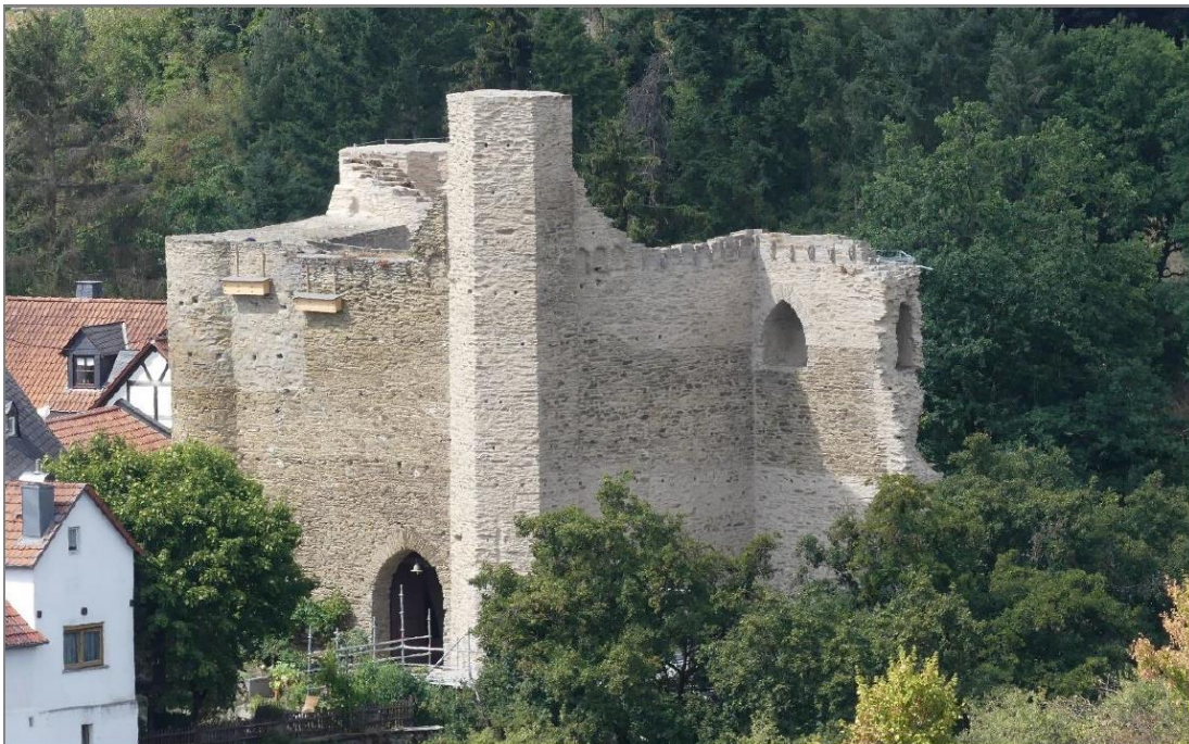
Oben: Burgruine nach der Sanierung
