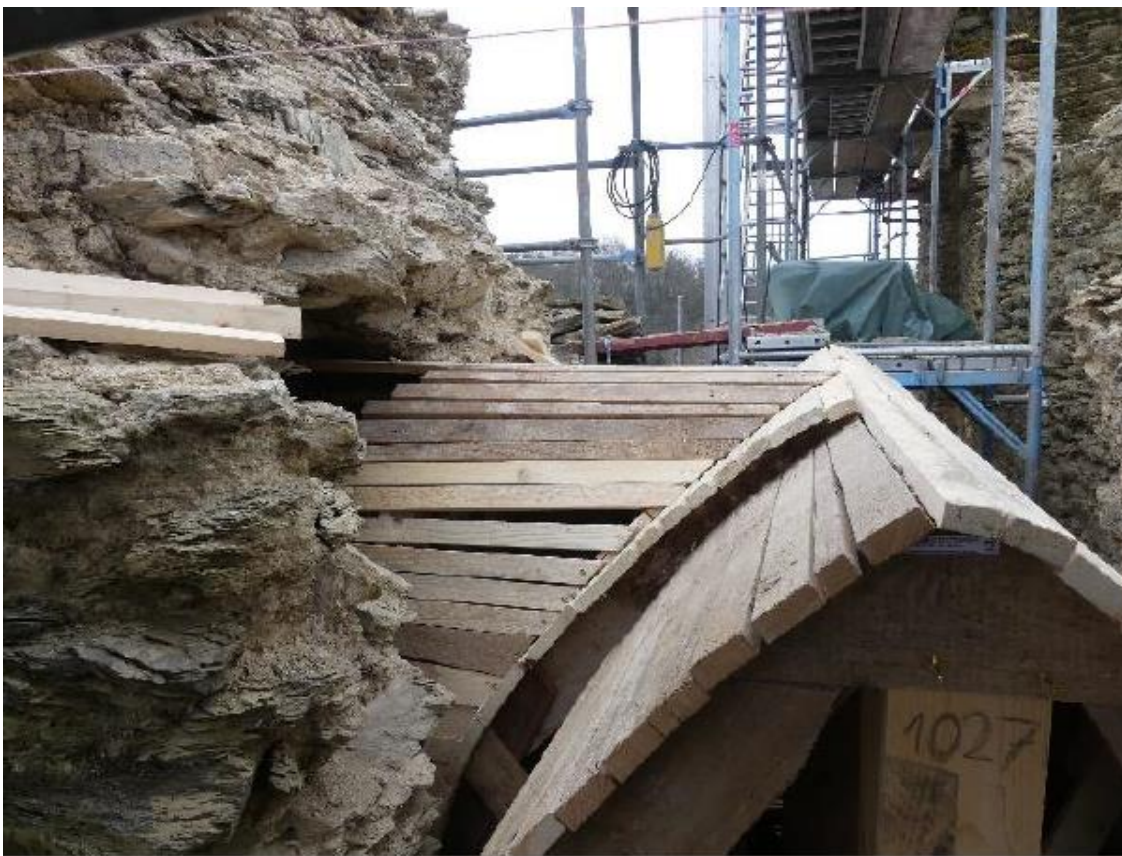
Aufmauerung eines Spitzbogens mittels Bogenschalung
