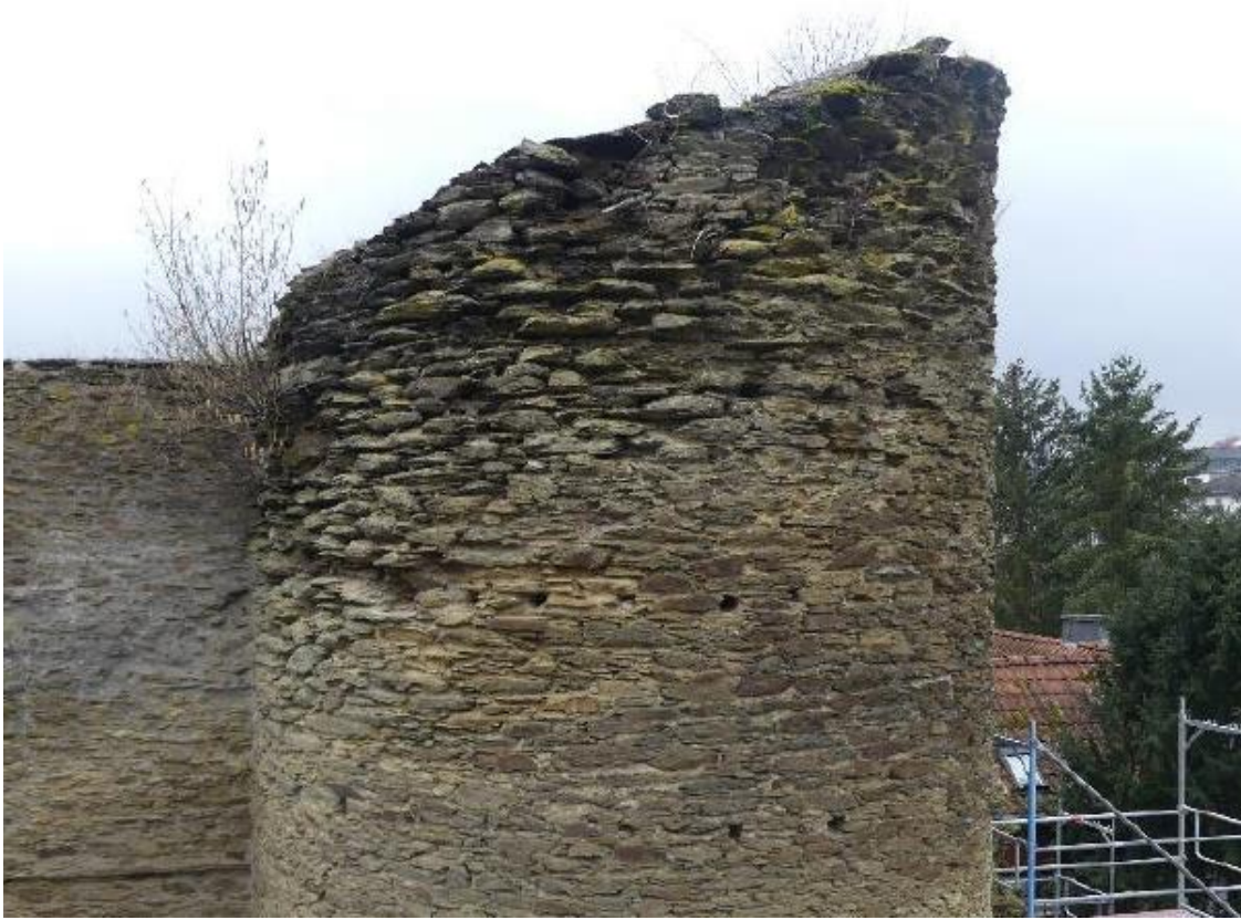
Ansicht Bergfried vor der Sanierung
