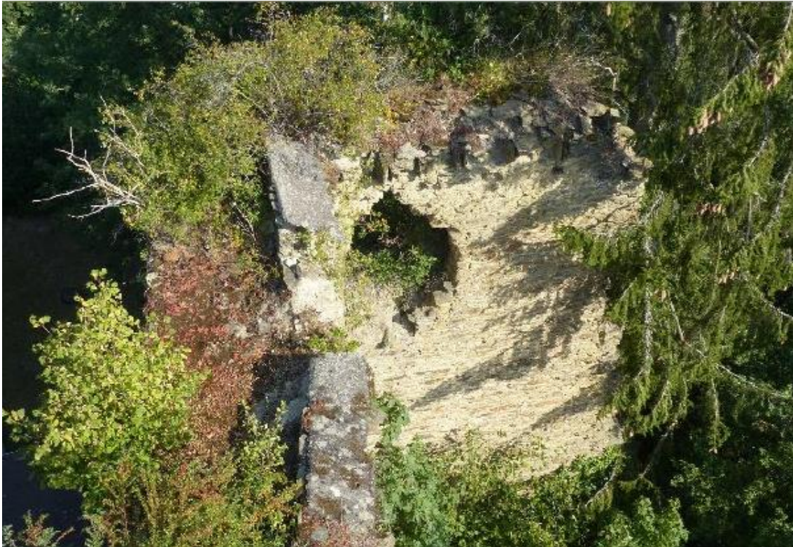
Überwachsene Mauerkrone vor der Sanierung
