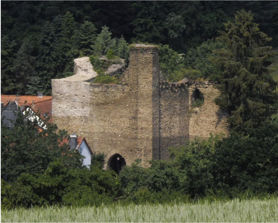
Burgruine vor der Sanierung
