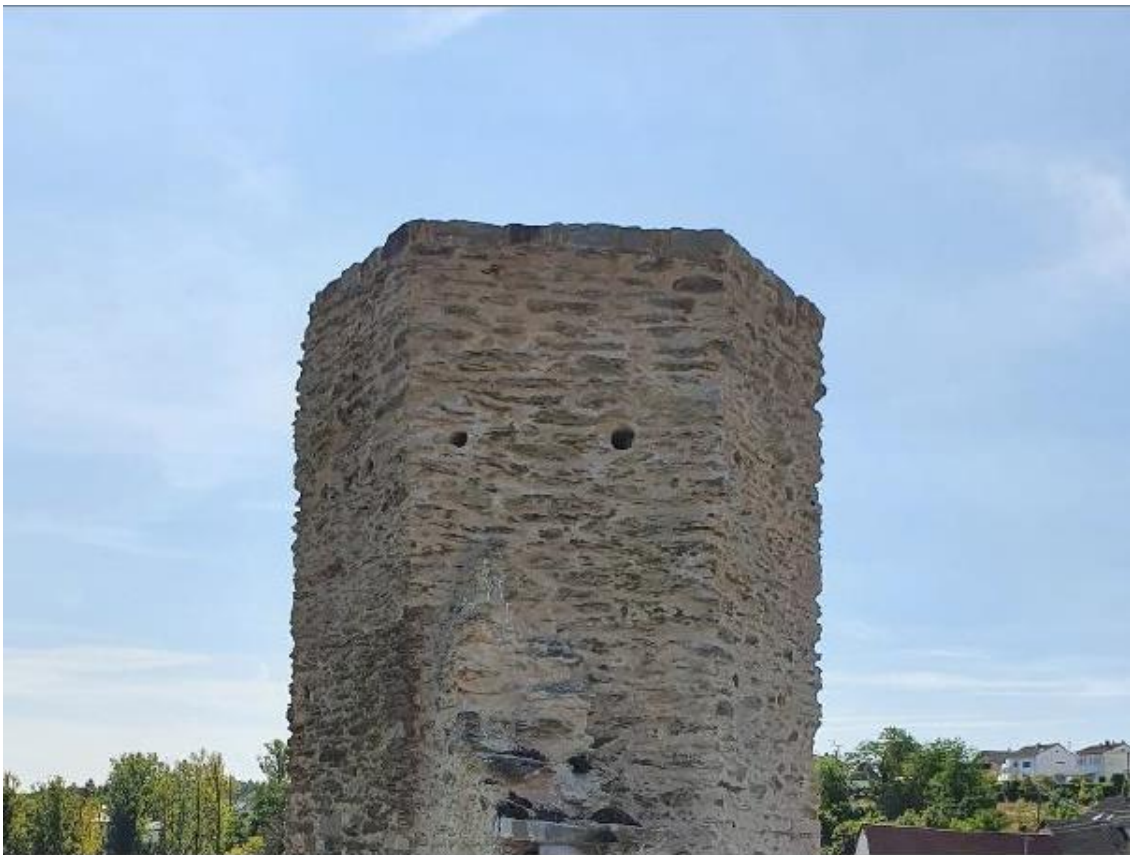
Ansicht Tournelle nach der Sanierung
