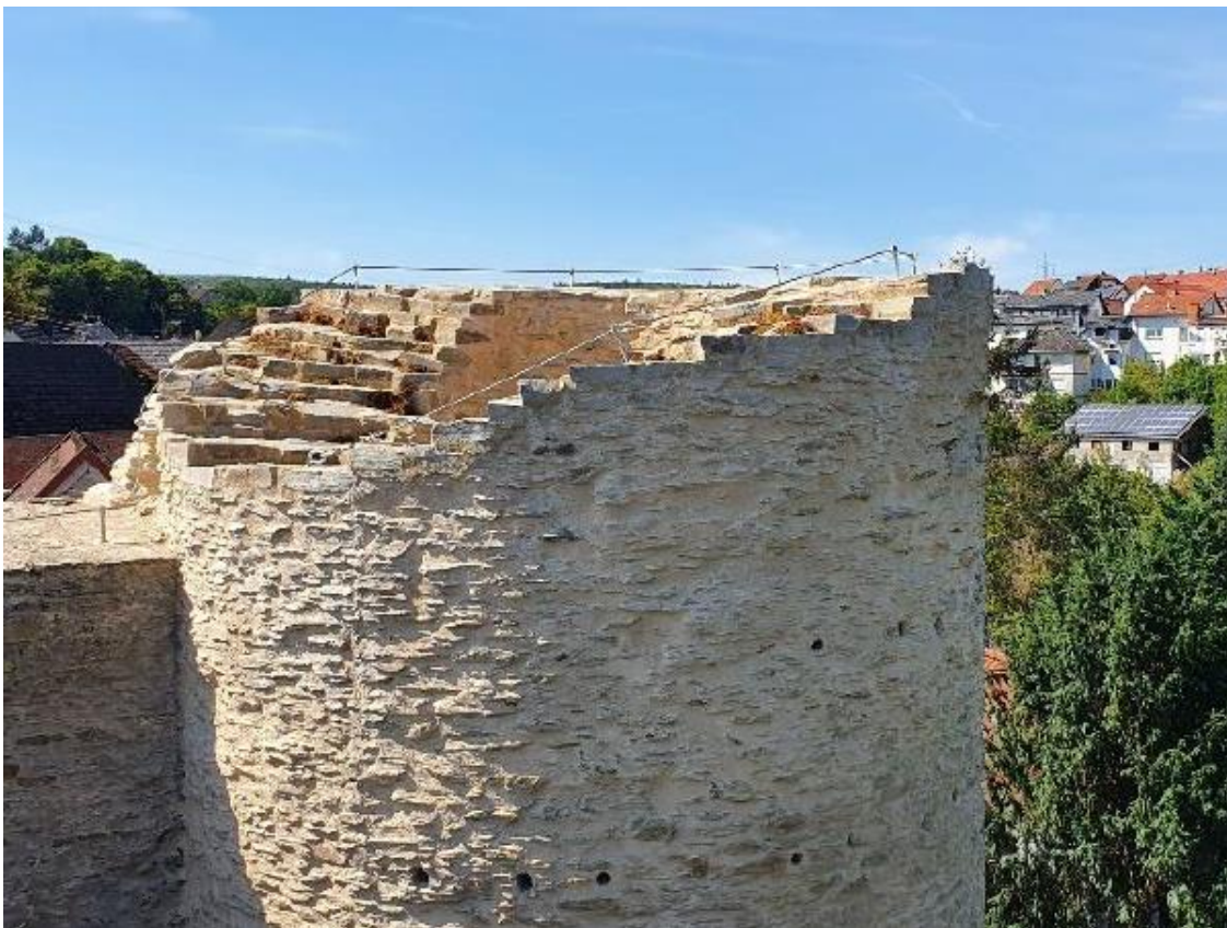
Ansicht Bergfried nach der Sanierung
