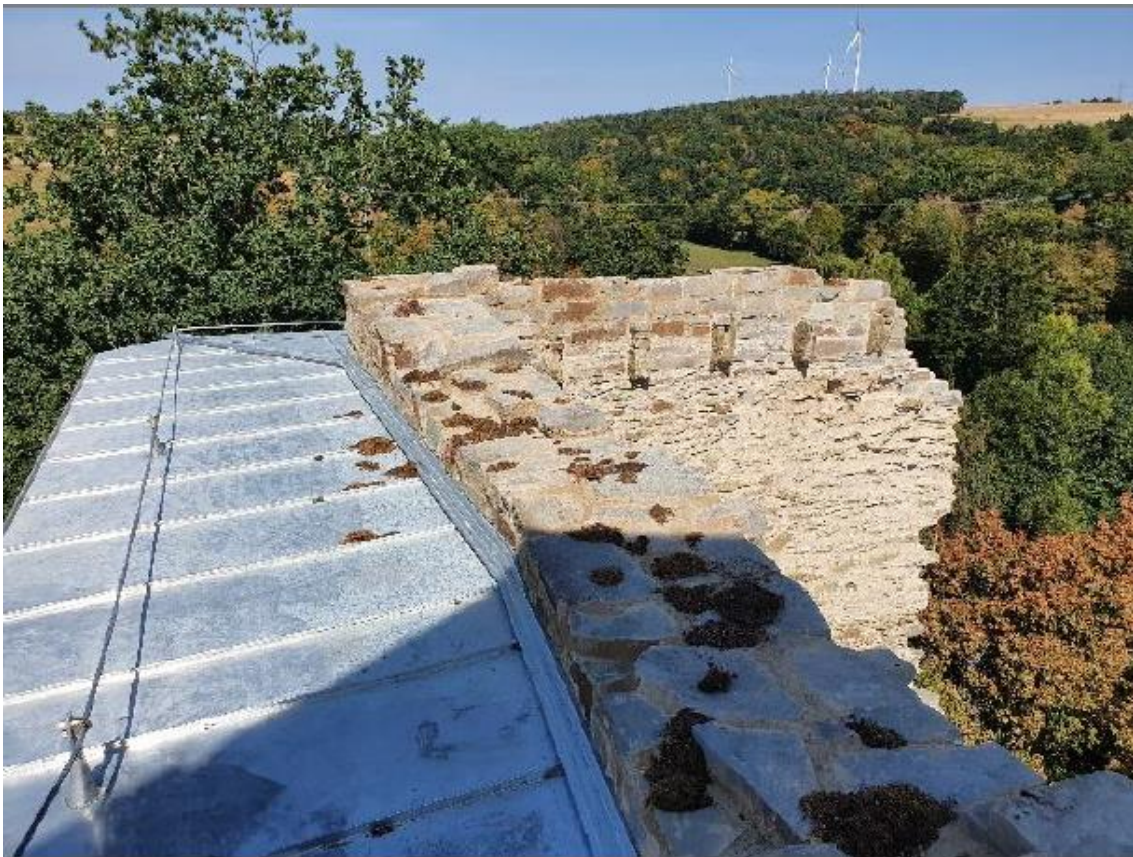
Ansicht des gleichen Mauerkronenabschnitts nach der Sanierung
