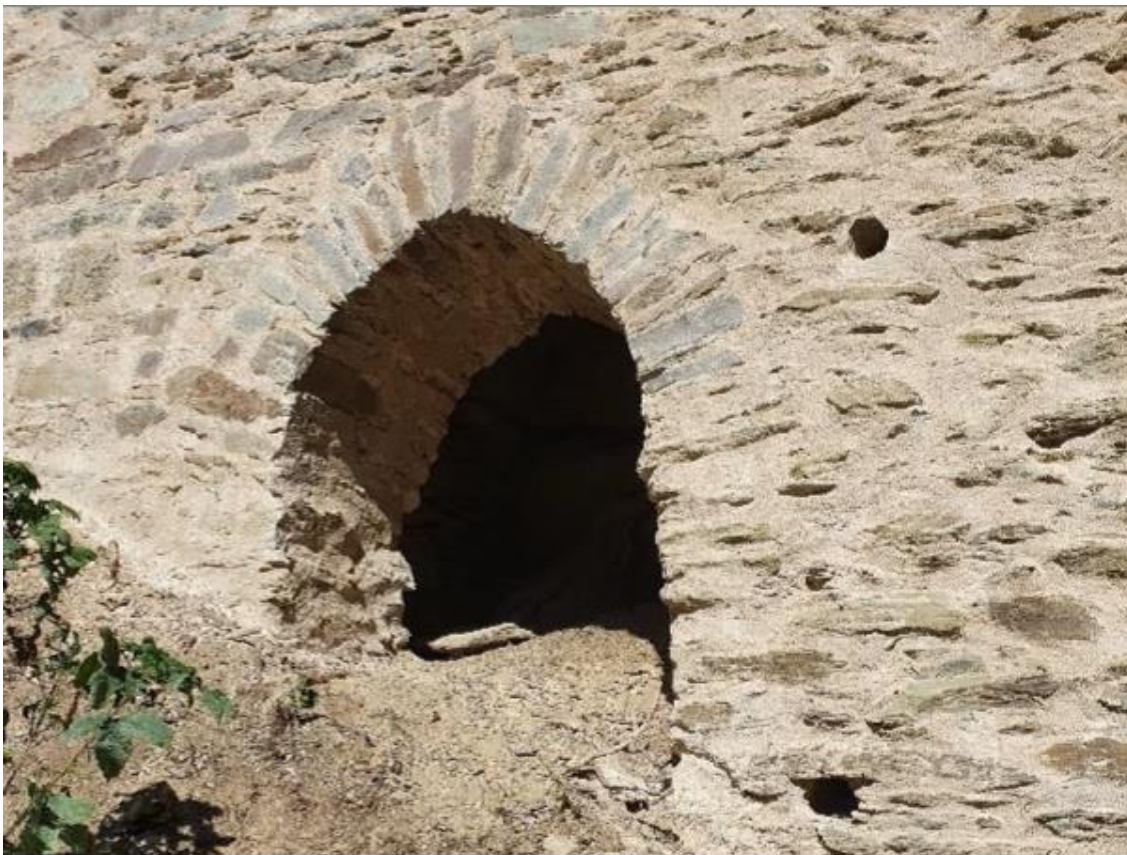
Spitzbogen nach der Sanierung
